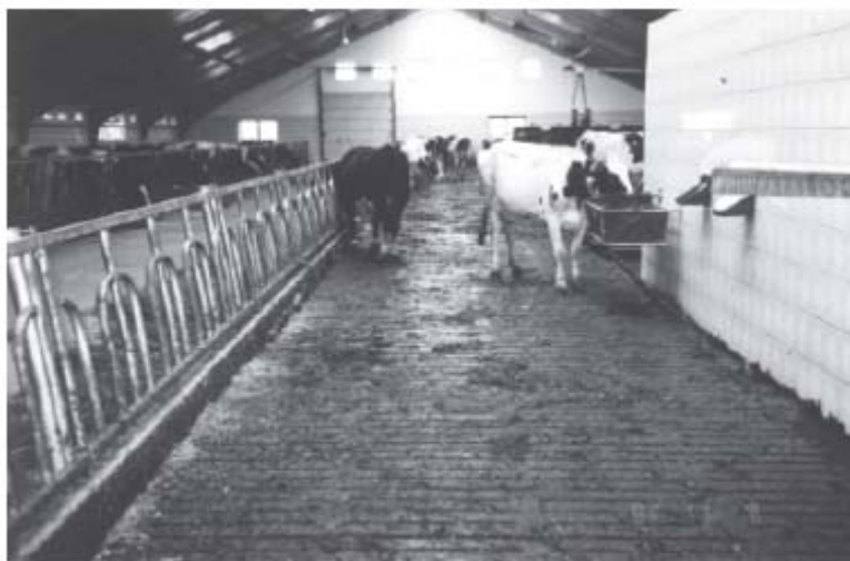
4.15. attēls. Šķidrmēslu savākšana mēslu kanālos pie barības galda
