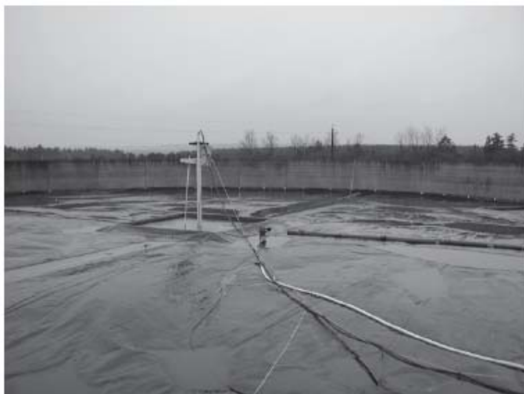
4.5.attēls. Peldošs sintētiskās plēves pārsegums
