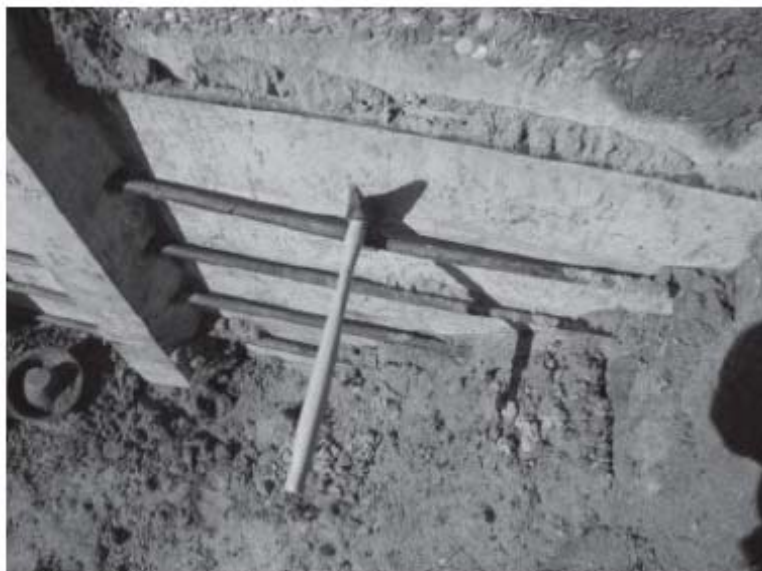
4.1. attēls. Trosēm jābūt atklātām, lai tās varētu pārbaudīt
