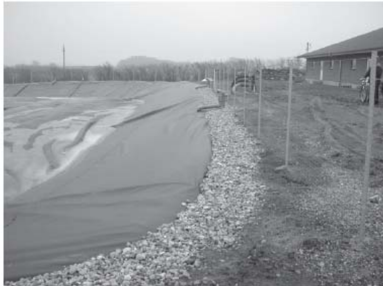
4.13. attēls. Lagūna tipa šķidrmēslu krātuve ar žogu un ventilācijas elementiem
