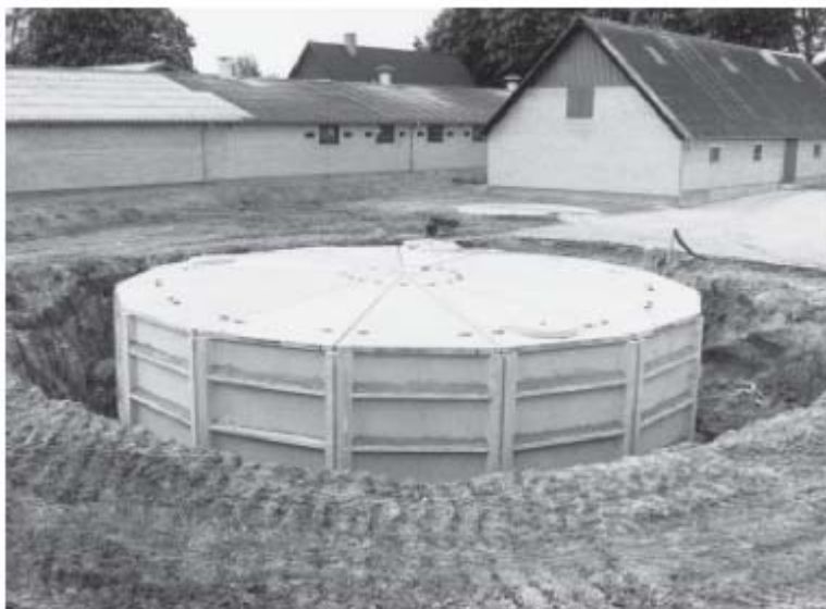
4.6. attēls. Betona pārsegums
