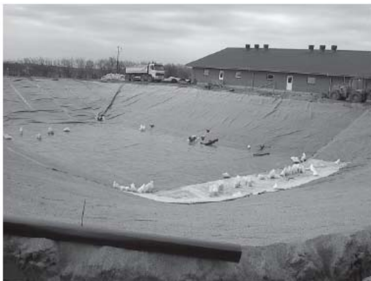
4.12. attēls. Lagūnas tipa šķidrmēslu krātuves būve
